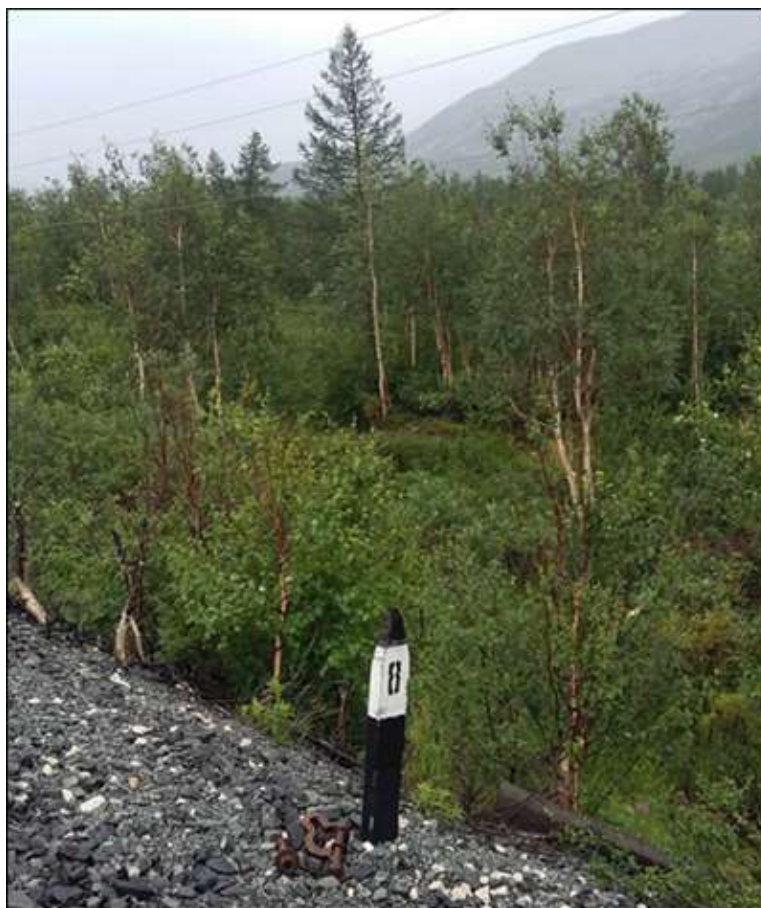
Рисунок 2.2 - Общий вид участка работ
